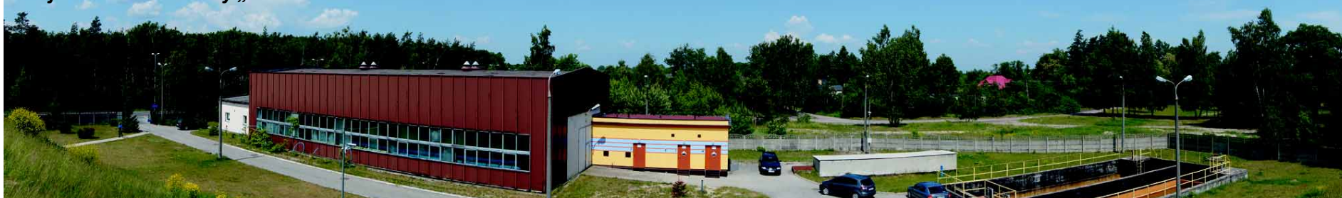
Stacja Uzdatniania Wody „Mokra”
