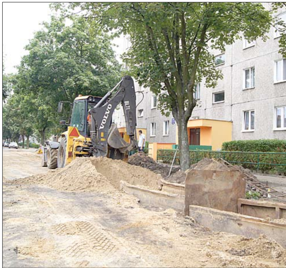
Budowa kanalizacji sanitarnej w ul. 11-go Listopada rozpoczęła się na początku lipca br. Do końca listopada 2011 roku powstanie tu kanalizacja grawitacyjna o łącznej długości 775 mb, co poprawi komfort bytowania mieszkańców oraz zwiększy atrakcyjność inwestycyjną terenu.
