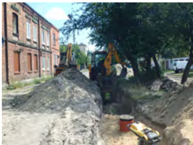
Budowa sieci kanalizacji sanitarnej w ul. Cehaka w Żyrardowie
