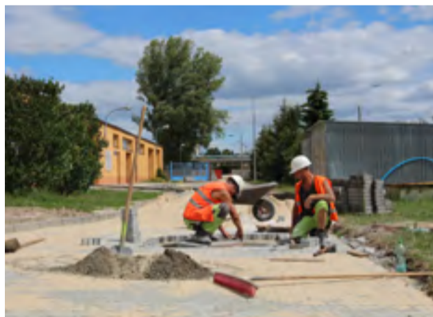
Budowa i przebudowa infrastruktury drogowej na terenie oczyszczalni ścieków w Żyrardowie
