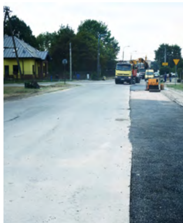
Budowa sieci kanalizacji sanitarnej w ul. Mireckiego w Żyrardowie
